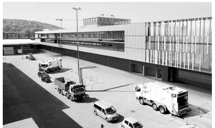
4 Logistikzentrum Hagenholz und Rechenzentrum, Objektkredit von 72,1 Mio. Franken | Seiten 12–14
