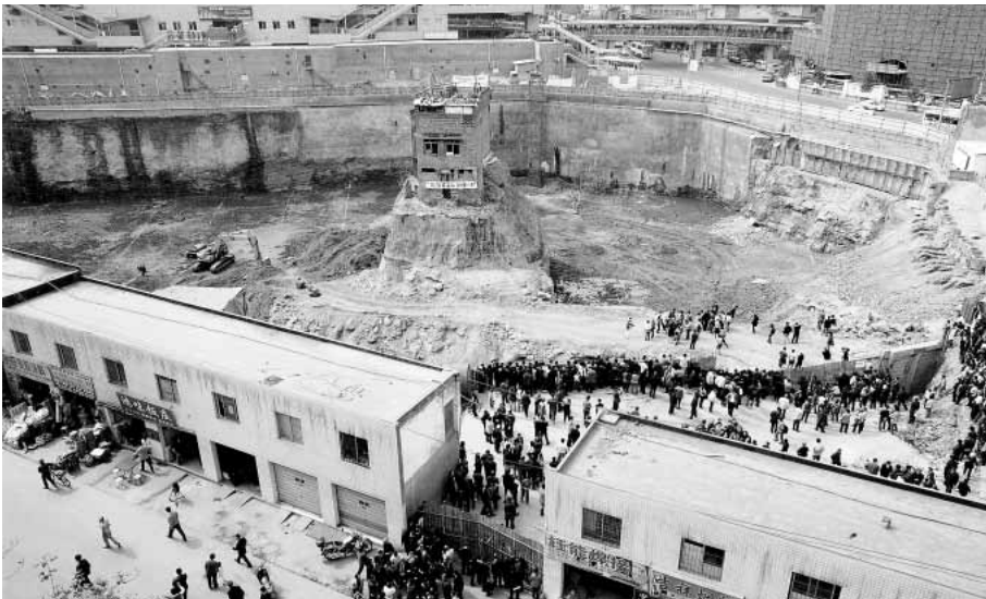
In der Mitte der riesigen Baugrube steht das Nagelhaus-Original in Chongqing. Auf die Gebäude im Vordergrund wiederum wird sich das Kioskgebäude beziehen.
