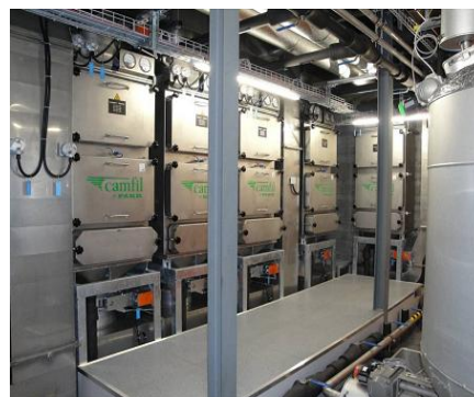
HEPA-Filteranlage
